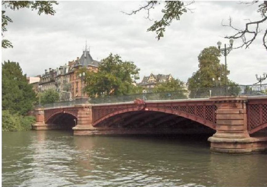
Pont d'Auvergne à Strasbourg 2008 REIKO
