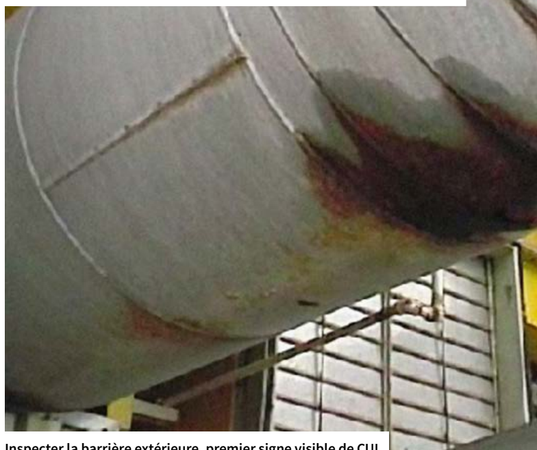
Inspecter la barrière extérieure, premier signe visible de CUI
