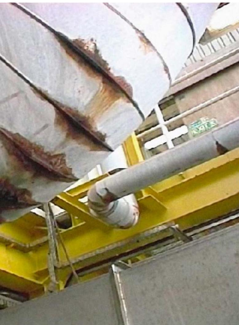
réduisant la température de surface, permettent d'éviter l'isolation traditionnelle par de la laine de roche, susceptible d'engendrer de la corrosion sous isolation. Il faut également bien établir une stratégie de contrôle raisonnée d'inspection au cours du cycle de vie.
