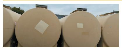
La réalisation d'un décapage secondaire sur des zones corrodées implique la mise à nu de l'acier. Pour reconstruire la protection anticorrosion, il est donc nécessaire d'y appliquer des retouches, avec un système de peinture compatible avec les anciens fonds qui sont conservés sur les zones adjacentes non corrodées. Cela peut être suivi d'une mise en peinture générale.
