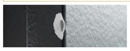
Des retouches de peinture sont réalisées pour remédier aux dégradations du film de peinture consécutives à des problèmes liés aux conditions de stockage, à la manutention, au transport et au montage sur site. Ces retouches sont également effectuées sur les zones de soudure. Dans certains cas, une procédure spécifique peut être établie (préparation de surface et application du système).
